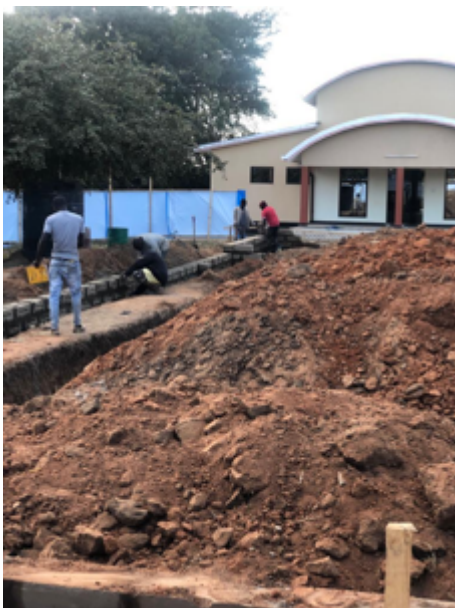
Arbeiten an den Fundamenten des neuen OP-Gebäudes
